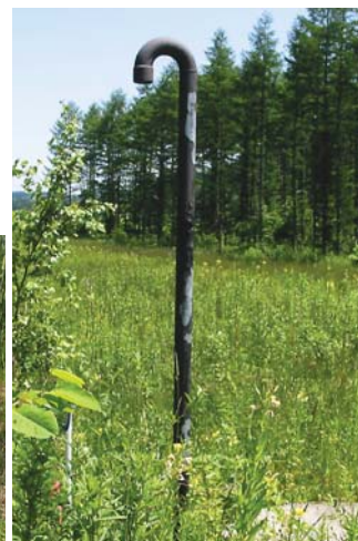
ようすいる 空気ぬきの管 用水路の空気ぬき用の管（左は配水幹線の、右は導水路の空気ぬき用管）。
