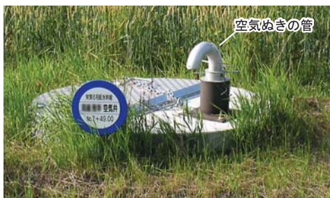
ようすいる 空気ぬきの管 用水路の空気ぬき用の管（左は配水幹線の、右は導水路の空気ぬき用管）。
