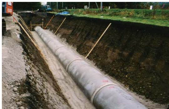
はいすいち どうすいる さつないがわどうすいる 配水池に水を送る導水路（札内川導水路）。
