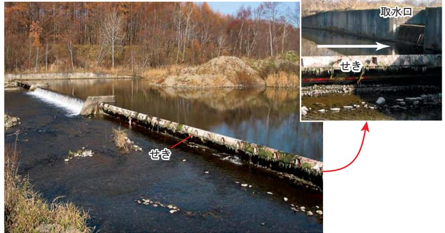
取水せき(※5)を造って水をため、岸の取水口から水を引きこむ。(音更川、土幌町) おとるけがわ
