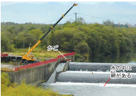
十勝川、千代田堰堤のさけ・ます捕獲場。クレーンで網(四つ手網)を引き上げてサケをとる。
