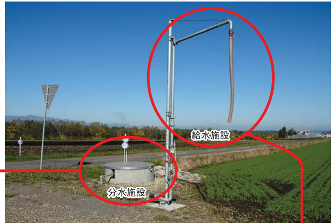
分水施設と給水施設。
