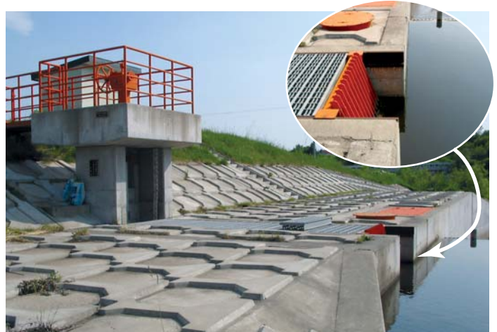
水の取り入れ口。ゴミが入らないよう、あみがある。(門のようなものは樋門 ひもん といって、堤防の下をくぐる水路。洪水のときとびらを閉める)
