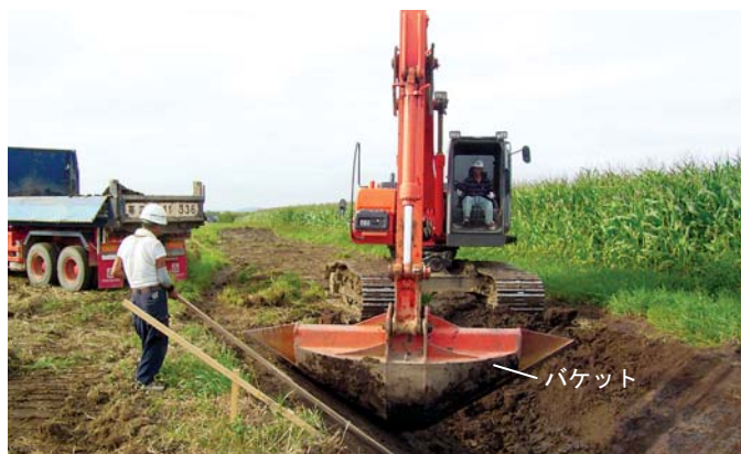
みぞほり用のバケットをつけたショベルカーで、排水路をほる。
