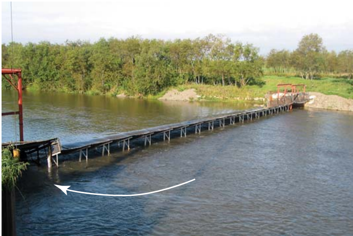
猿別川のウライ。サケは上り口を探して、矢印のワナに入る。
