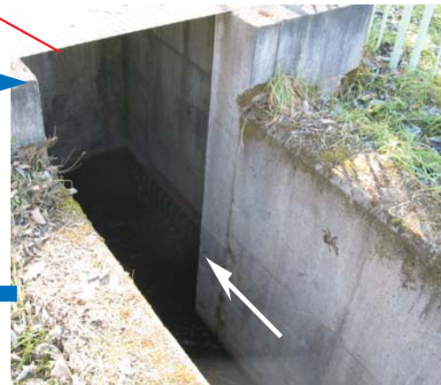
水は地下に造られたトンネル水路に入る。
