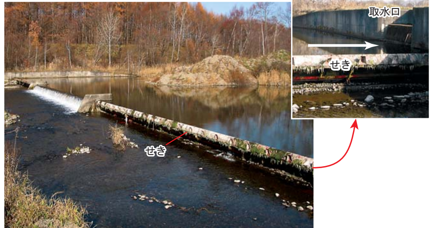
取水せき(※5)を造って水をため、岸の取水口から水を引きこむ。(音更川、土幌町)
