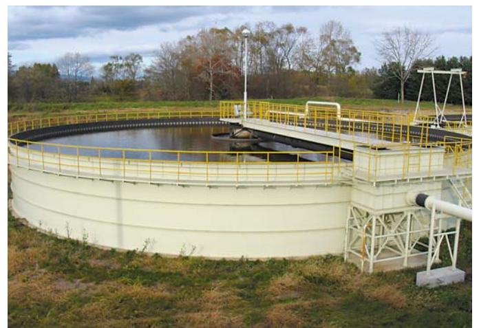
微生物(びせいぶつ)がしずみやすい固(か)まりとしたよごれを、沈(ちん)でんさせる池。
