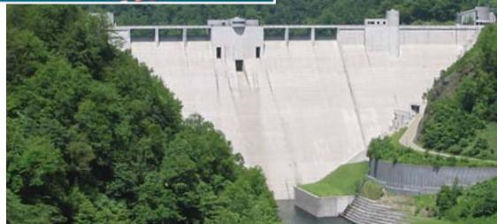
完成後の札内川ダム。左上はダムにためられた水。ダムにためることのできる水の量は、5千400万m<sup>3</sup> = 帯広市役所で約900杯分。
