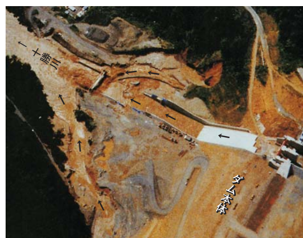
昭和56年(1981)工事中、洪水が起きた。真上から見たところ。
