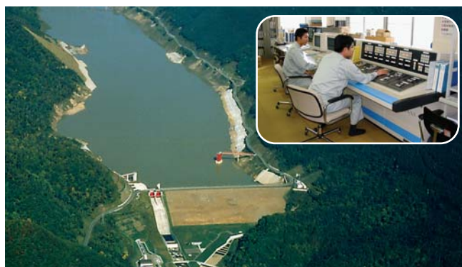
十勝ダム。右上は十勝ダムの操作室のようす。
