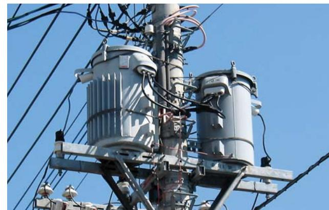
電柱にある変圧器。（→ 電柱と変圧器 p 45）
