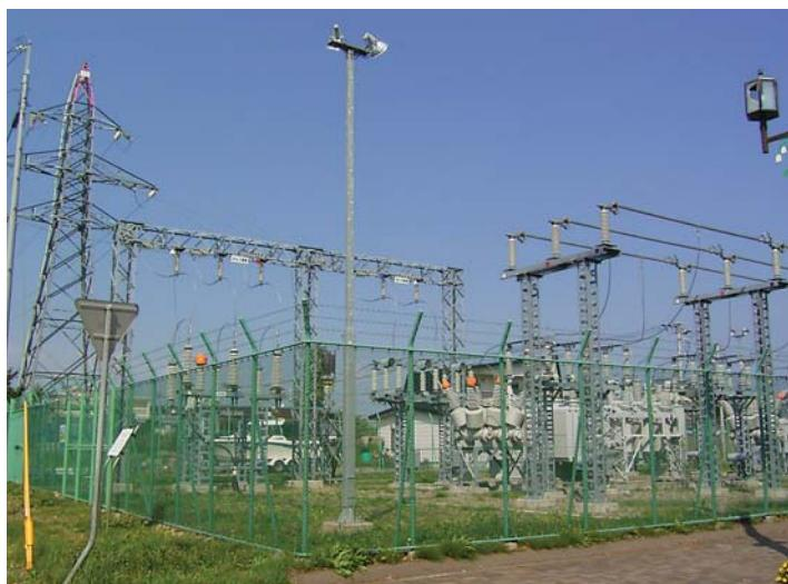
変電所。ここで電圧を調整して、地域に分けて配る。
