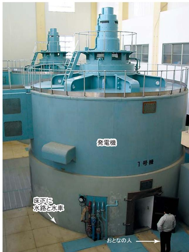
糠平発電所の発電機。床下に水路と水車がある。
