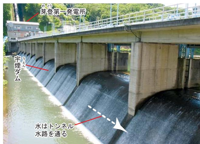
宇煙ダム(美里別川)。芽登第一発電所のすぐ前にある。ここで取られた川の水と発電所から出た水が、トンネル水路を通して送られる。
