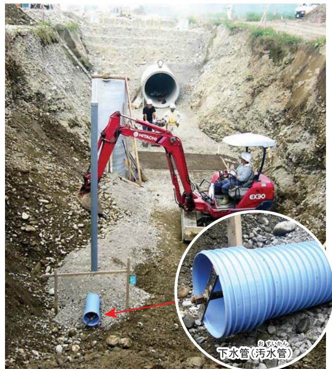
流しやトイレなどで使われ、よごれた水が流れる下水管。こうした管がつなげられて、下水処理場(※3)まで行き、最後は川に流される。
