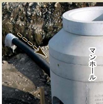
パイプを通って流れてきた水は、下水管（汚水管）に流れこむ。
