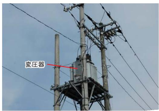
電柱に取り付けられた**変圧器**（トランス）。
