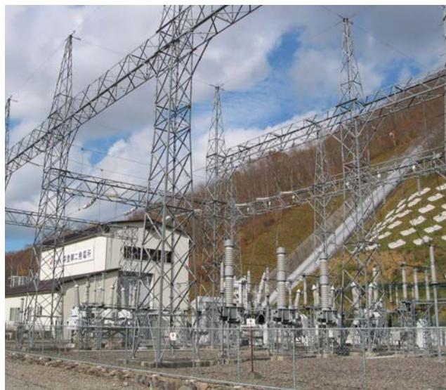
発電所にある変電施設。電気を遠くに送るために、電圧を高めます。
