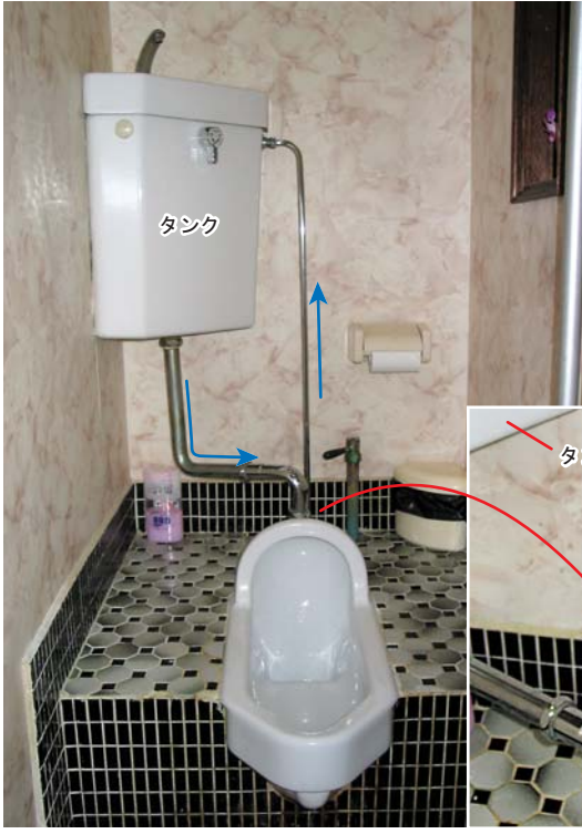
上のタイプの水洗トイレだと、タンクにつながっているパイプから、水が床下からきている(右)ことがわかる。
