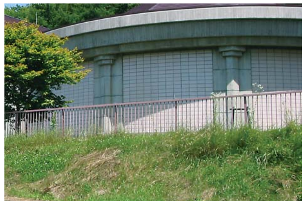
配水池の一つ。土でおおわれていないタイプ。
