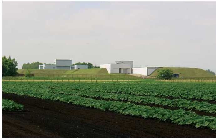
配水池の一つ。遠くから見ると「丘」のようにも見える。
