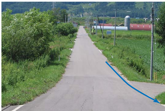
道沿いに送水管がうめてある。
