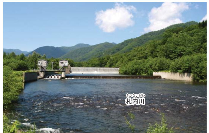
札内川から水を取るところ。せきが造られている。
