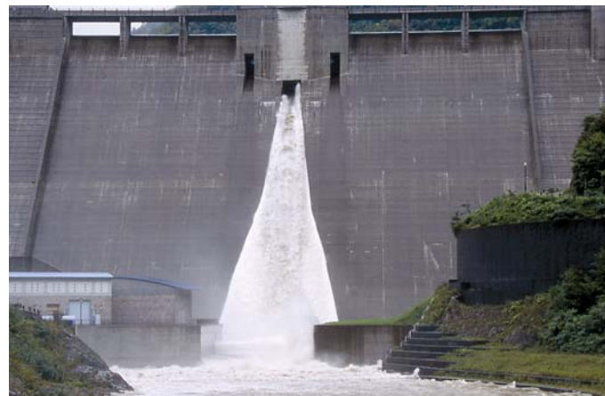
大雨のとき洪水をおさえるために水をため、ある程度洪水が落ち着いたところで、水を流す札内川ダム。
