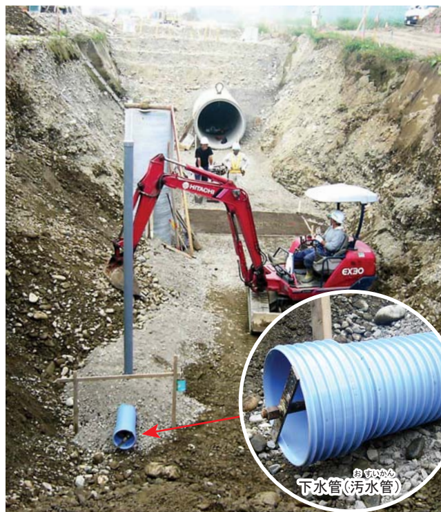
流しやトイレなどで使われ、よごれた水が流れる下水管。こうした管がつけられて、下水処理場(※3)まで行き、最後は川に流される。
