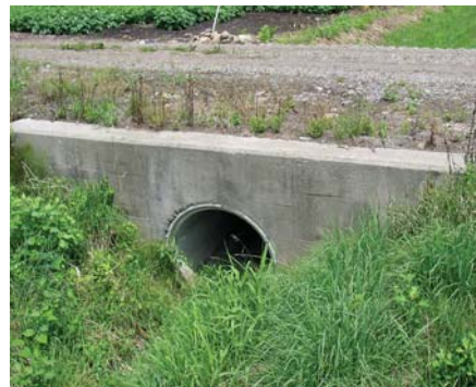
パイプカルバート。
