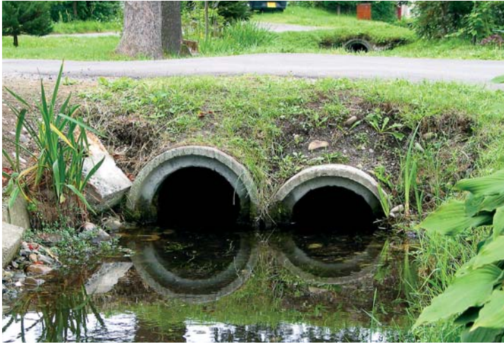
道の下を通るパイプカルバート。
