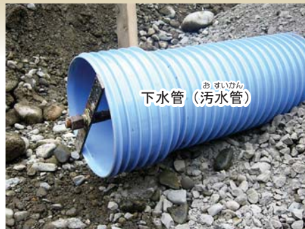
パイプを通して流れてきた水は、下水管（污水管）に流れこむ。
