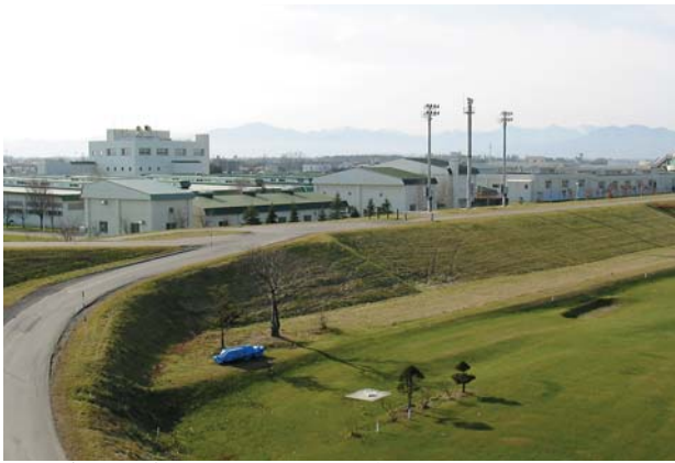
とかがわりゅういさげすいどうじょうか おびひろし 「十勝川流域下水道浄化センター」(帯広市西18条北3丁目)。 帯広市・音更町・芽室町・幕別町からの水を処理する。
