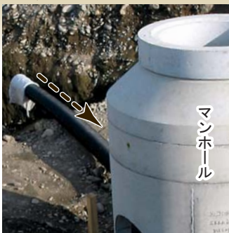
パイプを通して流れてきた水は、下水管（污水管）に流れこむ。
