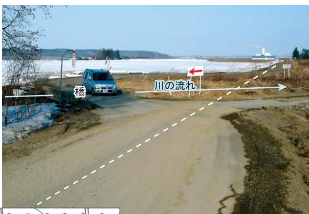
美蔓川をわたる道のカーブ。 道を点線のようにまっすぐにすると、橋を川に対して斜めにかけないといけ な ない。
