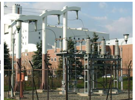
特別高圧開閉所。ここから北海道電力を通じて家庭などに電気を送る。
