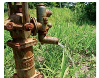
地下水をくみ上げる井戸。
