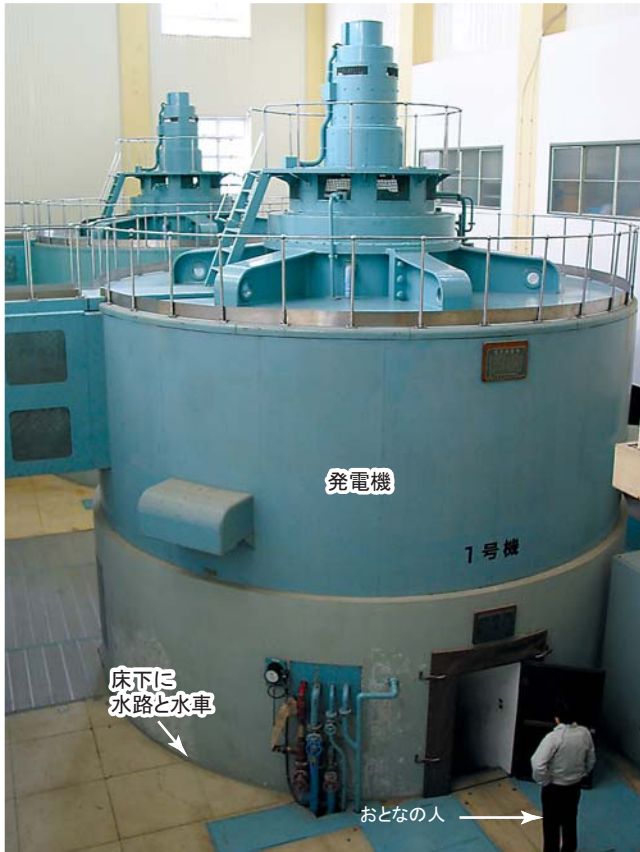
めかひらはつてんしよ 糠平発電所の発電機。床下に水路と水車がある。
