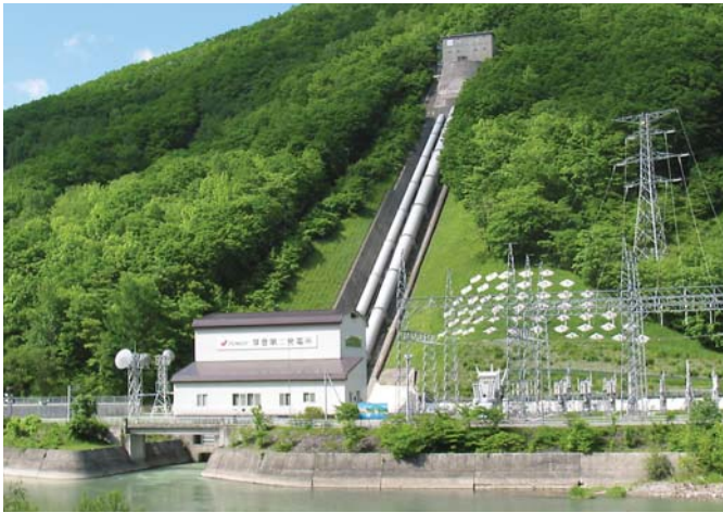
めとうだいに はつでんしよ ひりべつがわ としべつがわ 芽登第二発電所。美里別川(利別川支流)。
