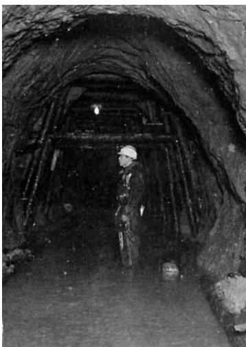
工事中の水路のトンネル。 あしよろはつでんしよ (足寄発電所に向かう水路) (「糠平建設所 思い出のアルバム」電源開発(株)糠平建設所、1956 より)
