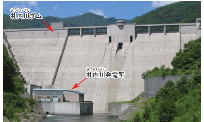
札内川ダムのすぐ下にある札内川発電所。
