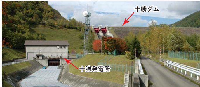
十勝ダムのすぐ下にある十勝発電所。
