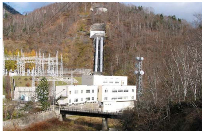
糠平発電所。糠平ダムから約3km下流。
