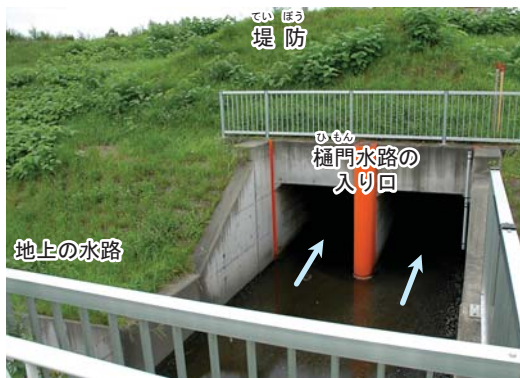
② 堤防下(ていぼう)を通る、樋門水路(ひもんすいろう)への入り口。多くの場合、地上の水路(じょうじょうのすいろう)の水もいっしょにされる。
