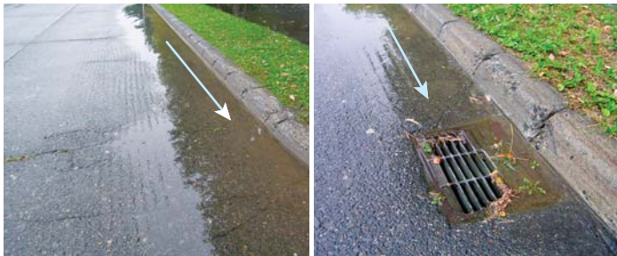
③ 道路のはしを流れる。 ④ あみのついた穴に流れこむ。この穴は雨水ますにつながる。
