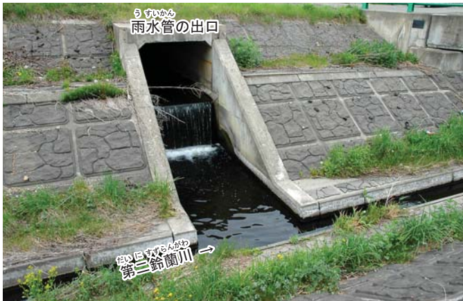
岸につくられた出口から、直接川に流れこむ場合(第二鈴蘭川・音更町)。
