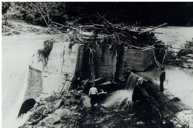
土砂によってうまってしまい、流木が引っかかっている農協発電ダム。昭和30年(1955)7月。
