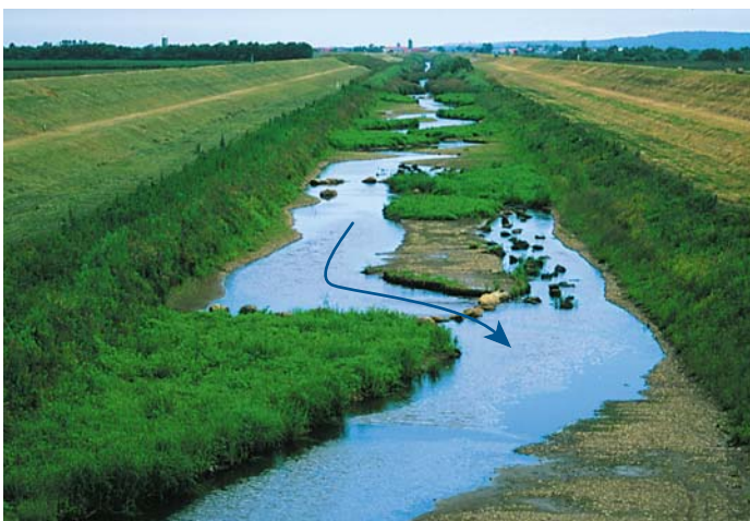
洪水の時にはまっすぐ流れ、水が少ない時には曲がって流れるように工事をした川。下頃辺川(浦幌町)。
