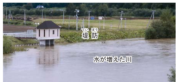
堤防があると増えた川の水を流すことができる。利別川・高島。
