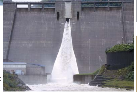
(右) 雨が落ちつき、ためた水を流しはじめた札内川ダム。
