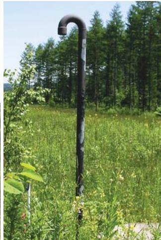
用水路の空気ぬき用の管(左は配水幹線の、右は導水路の空気ぬき用管)。
