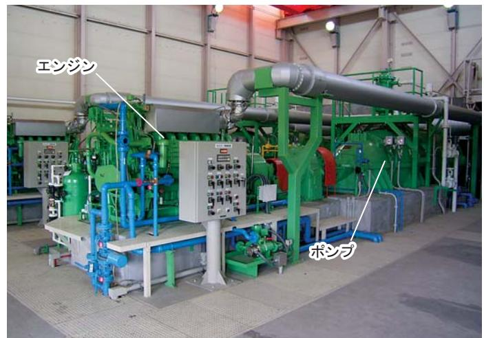
排水機場にあるポンプ(育素多排水機場)。排水の原理は左上のイラストと同じだが、仕組みはもう少し複雑である。
