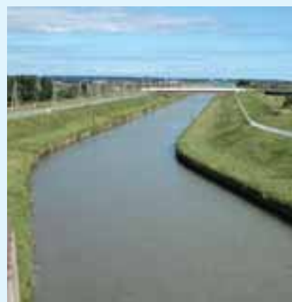
浦幌十勝導水路。
