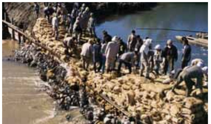
土のうなどによって十勝太(浦幌町)へ向かう流れが止められた。「十勝川が止まった!」との声が上がったという。(写真:『十勝川写真で綴る変遷』より)
