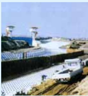
工事中の導水路。後ろが導水門。(写真:『十勝川写真で綴る変遷』より)
