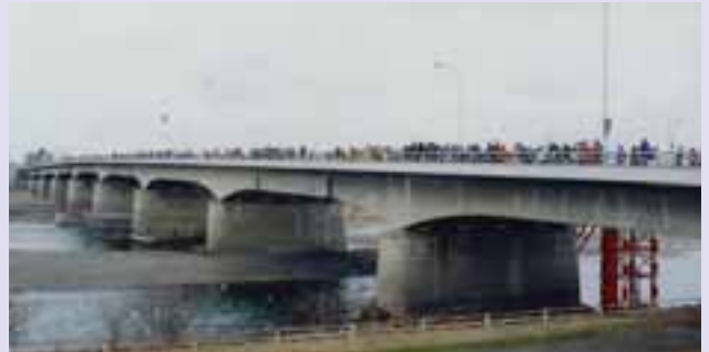
旧十勝大橋。昭和15年(1940)～平成7年(1995)。
