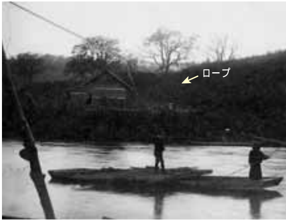
利別川の信取渡船(3:池田町)。ロープ(矢印)が張ってある。(写真:『池田町懐かしのアルバム』より)
