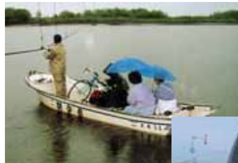
(上)旅来渡船。人と自転車、バイクまでをわたした。国道336号の一部で、平成4年まであった。(写真:『十勝川写真で綴る変遷』より)
