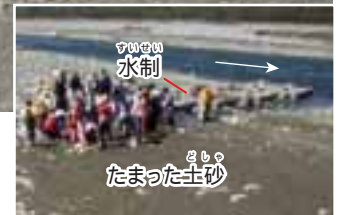
しばらくたった札内川の水制（帯広市）。下流側に土砂がたまっている。
