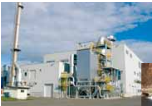
(上)土幌町のでんぷん工場(土幌町農業協同組合澱粉工場)。
