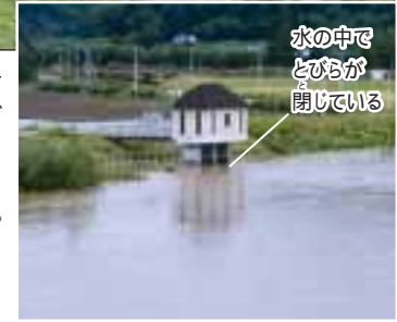
(上) 音更川の樋門(音更町)。堤防の下をくぐるトンネル水路ととびらからなる。
