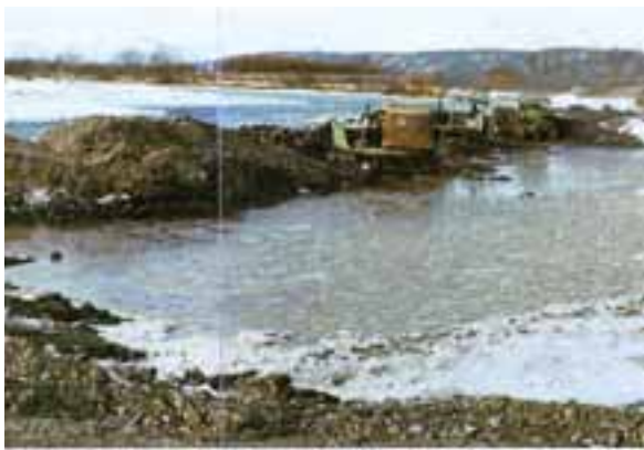
昭和39年(1964)におこなわれた、川の流れを変える工事。 (写真:『十勝川写真で綴る変遷』より)
