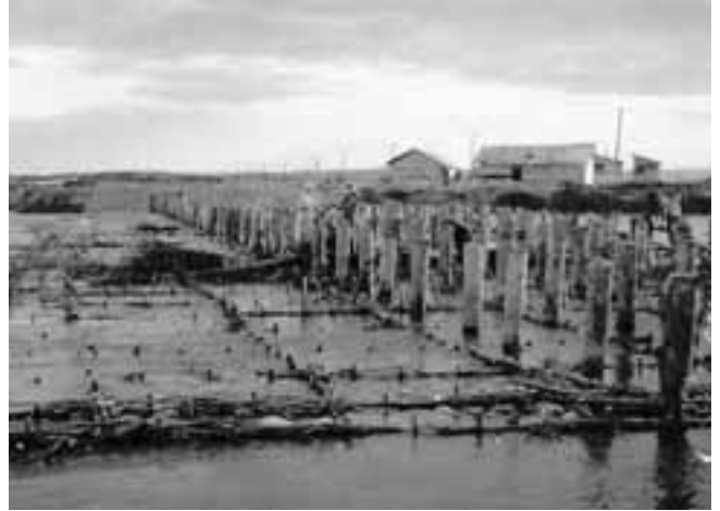
粗朶をしき、並杭の水制をつくったところ。
