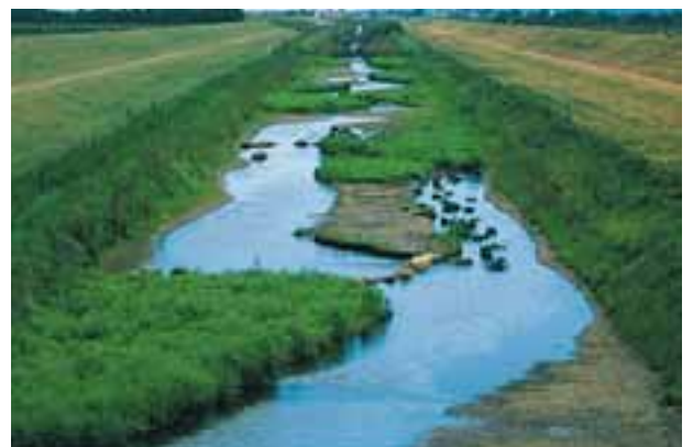
下頃辺川(浦幌町)では、洪水が流れやすいまっすぐな水路の中に、ふだんは曲がって流れるような水路がつけられた。
