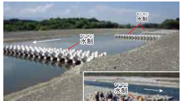
（上）できたばかりの十勝川の 水制（清水町）。積み上げられたブロックが流れにつき出している。（矢印は流れ）
