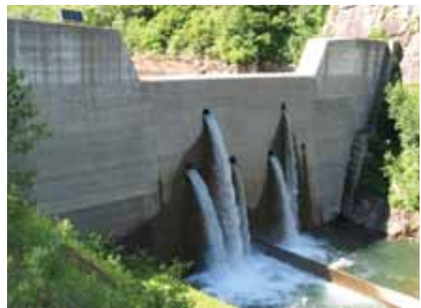
戸鶯別川にある砂防えん堤のひとつ(戸鶯別川第8号砂防えん堤:帯広市)。高さ20m以上ある。砂防えん堤には高さ数mの小さなものもある。
