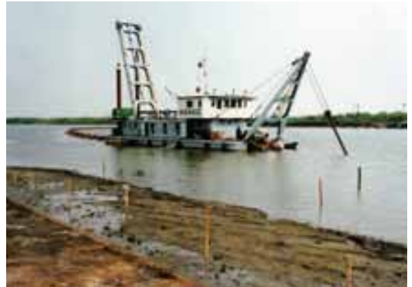
川底の土砂を水ごと吸い上げてしゅんせつするポンプ船。土砂は河川敷の「排泥池」で水をぬいたあと、堤防づくりなどに使われる。 (写真: 『十勝川写真で綴る変遷』より)
