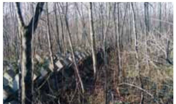
できあがって10年以上たった十勝川の水制（清水町）。水制の周りに土砂がたまって「陸」になり、林ができています。
