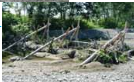
（左）「聖牛」。川の流れの中なのだが、つくるときには土砂で囲み、川の水が来ないようにしてある。完成後、水を流す。
