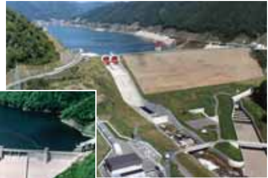
(上) 十勝ダム(十勝川上流・新得町)。(左) 札内川ダム(札内川上流・中札内村)。どちらも治水のほか、発電用水などをためる役割も持つ「多目的ダム」。
