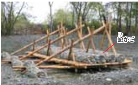
（左）「聖牛」。川の流れの中なのだが、つくるときには土砂で囲み、川の水が来ないようにしてある。完成後、水を流す。
