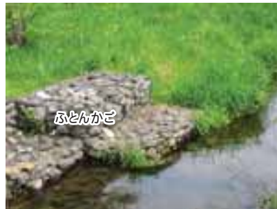
「ふとんかご」による護岸。針金のカゴに石が つめてある。機関庫の川（帯広市）。
