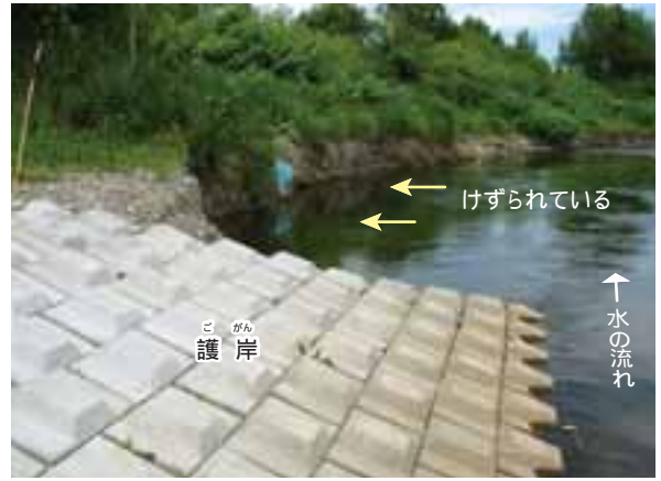
ブロックに太い針金を通してつないだ護岸。おくの護岸がないところでは、川岸が水の力でけずられている。
