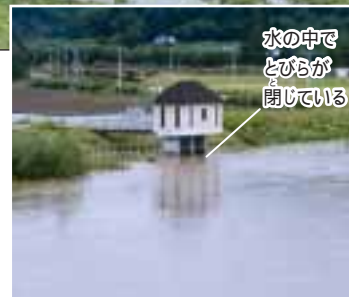
(上) 音更川の樋門(音更町)。堤防の下をくぐるトンネル水路ととびらからなる。
