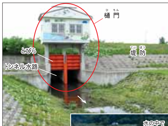
(上) 音更川の樋門(音更町)。堤防の下をくぐるトンネル水路ととびらからなる。
