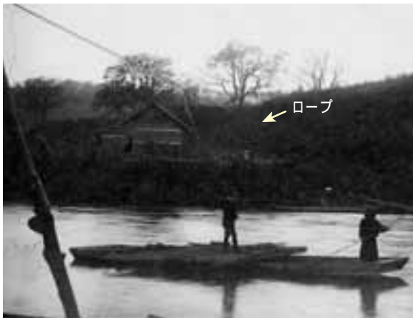
利別川の信取渡船(3:池田町)。ロープ(矢印)が張ってある。(写真:『池田町懐かしのアルバム』より)
