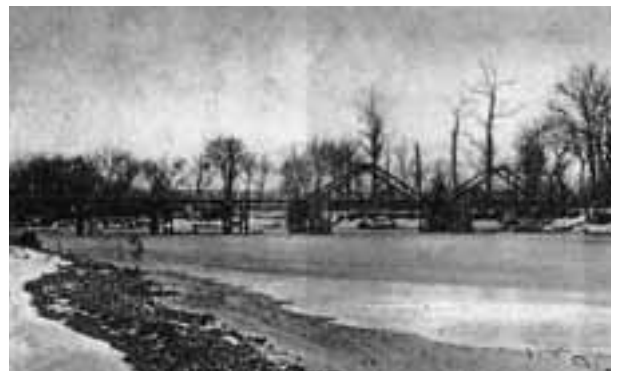
明治38年(1905)にかけられた開成橋。
