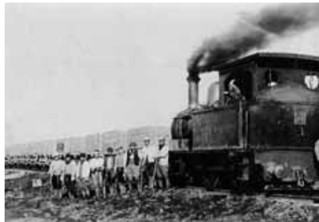
作業をした人たちと、蒸気機関車。左後ろが土運車。
