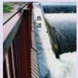
えん堤の角が落としてあるところと 右岸側（4）にある魚道、取水口。
