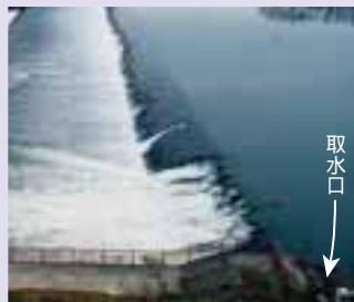
えん堤の角が落としてあるところと 右岸側（4）にある魚道、取水口。
