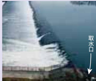
えん堤の角が落としてあるところと取水口。
