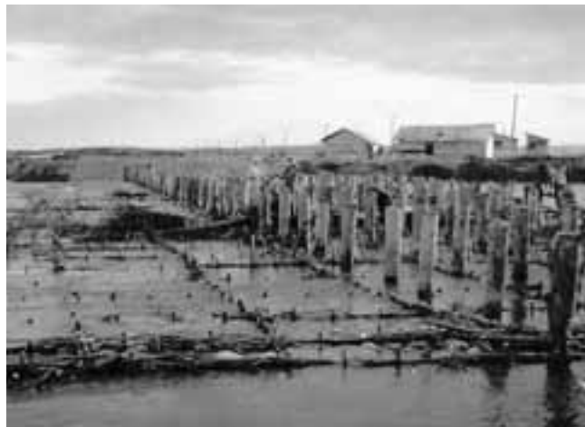
粗朶をしき、並杭の水制をつくったところ。
