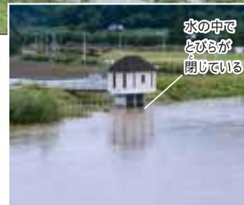
(右) 洪水の時の利別川の樋門(池田町)。水の中でとびらが閉じている。
