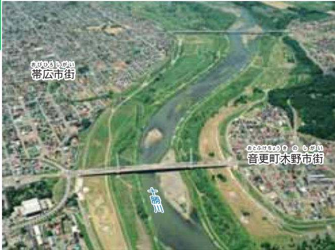
十勝大橋付近の十勝川。今では周りに住宅地が広がっているが、かつてはほとんどが森や草原、湿地であり、十勝川の流れもたびたび変わった。
