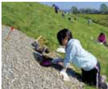
(右) 十勝川の堤防に木の苗を植えているところ。「治水の社」として、水害を防ぐ意味がある。
