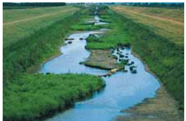
下頃辺川(浦幌町)では、洪水が流れやすいまっすぐな水路の中に、ふだんは曲がって流れるような水路がつけられた。
