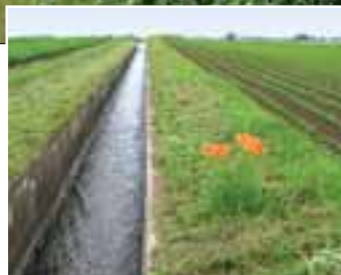
(右) 十勝頭首工で取られた水は、土幌町と音更町の用水路を流れる。
