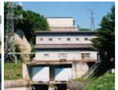
本別発電所(本別町)。糠平ダムの水は、ここまで送られてきて利別川へ流される。
