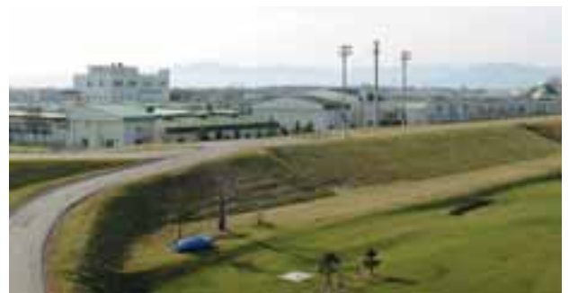
「十勝川流域下水道浄化センター」(帯広市西18条北3丁目)。帯広市・音更町・芽室町・幕別町からの水を処理する。
