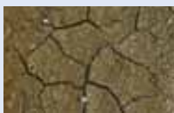
水たまりあとのひび割れ。
