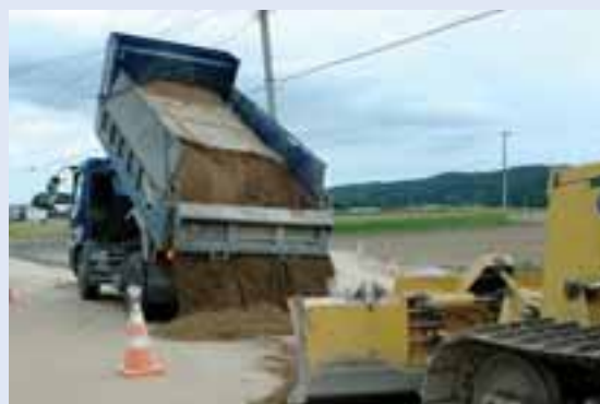
道路工事。アスファルトや砂利をしく前に、「火山灰」をいれているところ。（協力：河向組）
