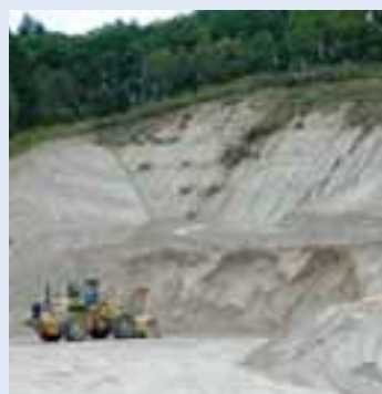
道路工事。アスファルトや砂利をしく前に、「火山灰」をいれているところ。（協力：河向組）
