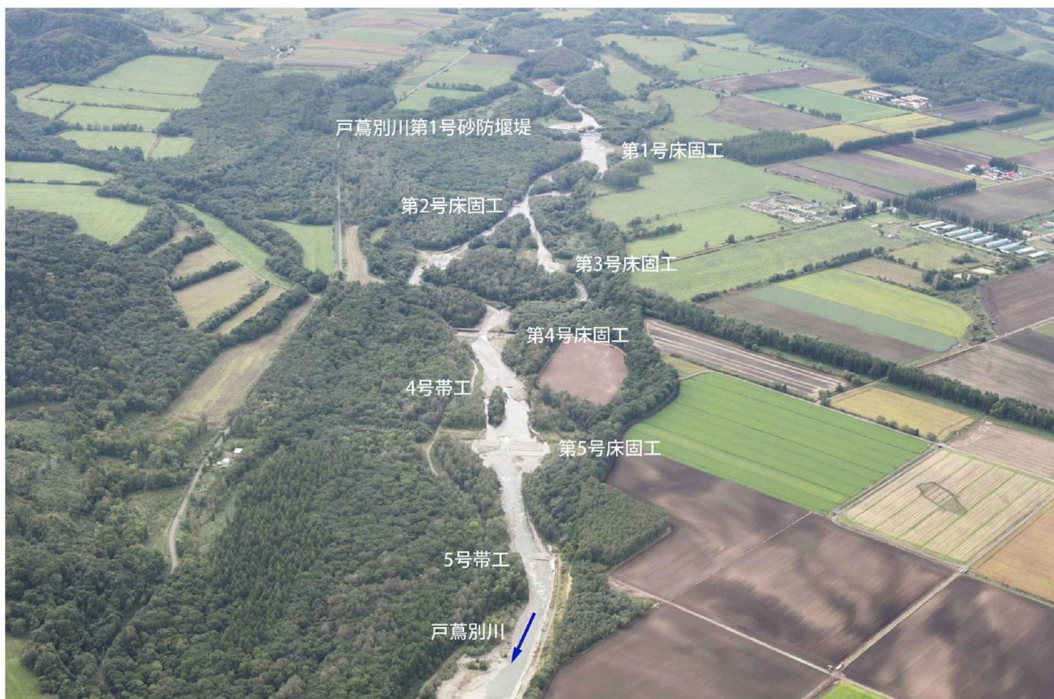
T06_戸蔦別川第 1 号床固工
