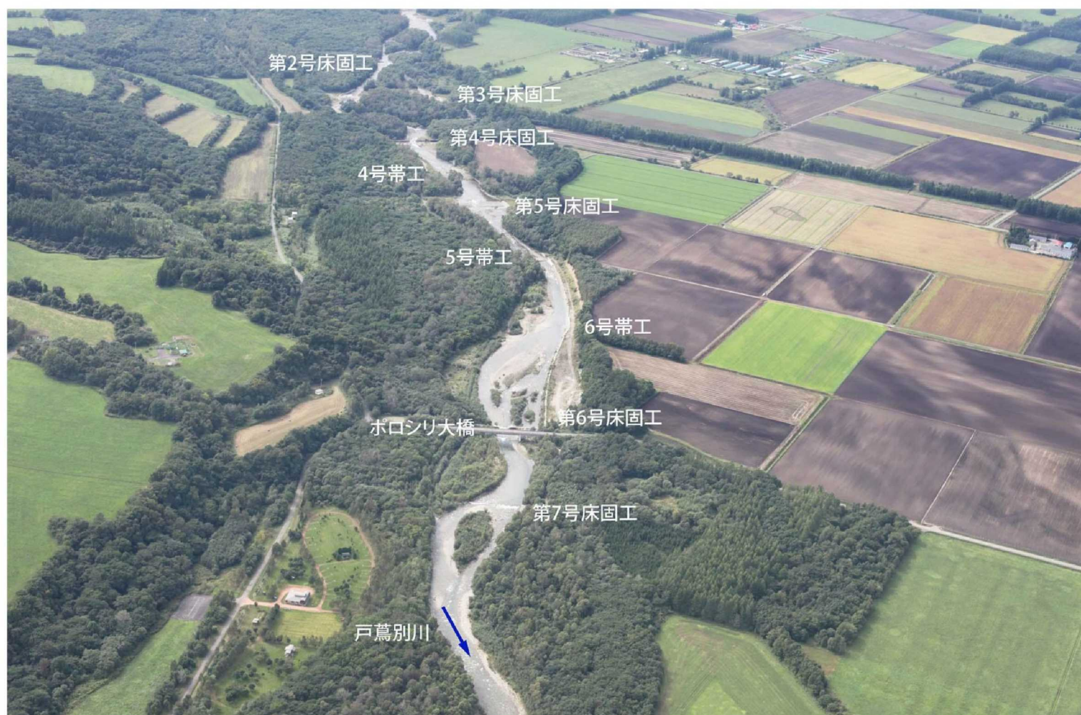
T04_戸蔭別川第 7 号床固工
