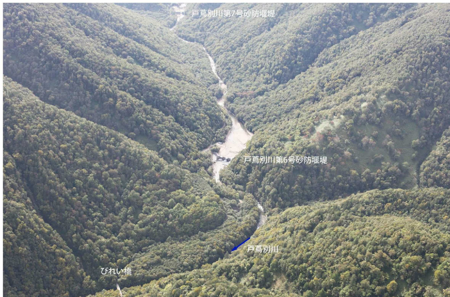
T17_戸蔦別川第6号砂防えん堤
