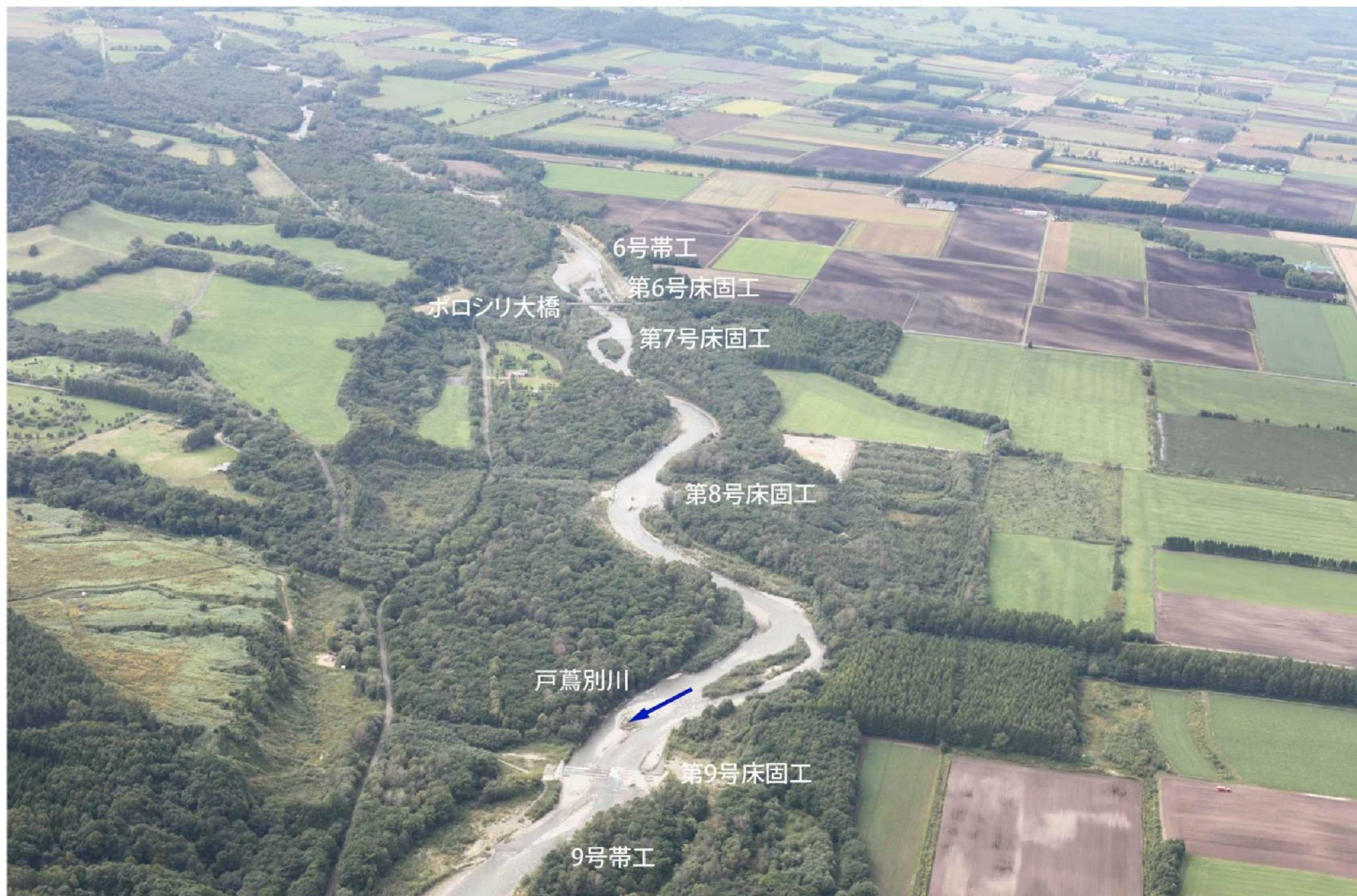
T03_戸蔭別川第 9 号床固工
