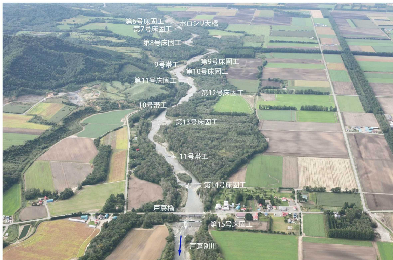
T02_戸蔦別川第 15 号床固工
