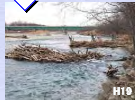
木と石による伝統工法「聖牛」とその4年後
