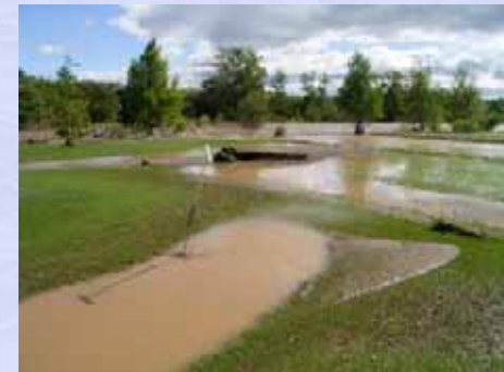
増水後の高水敷
