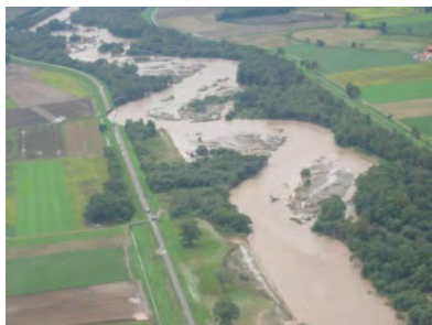
写真-1 平成23年9月出水時の状況 (KP18.2付近:音更町東音更)
