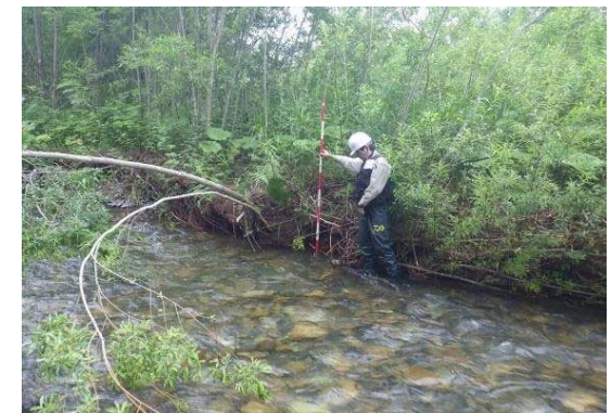
写真② 水際の浸食状況
