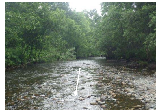
写真① 旧流路：H28. 7. 13 (6月下旬出水後)
