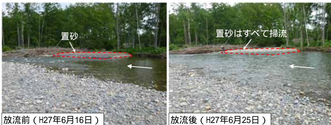
図-1 フラッシュ放流による置砂の掃流状況
