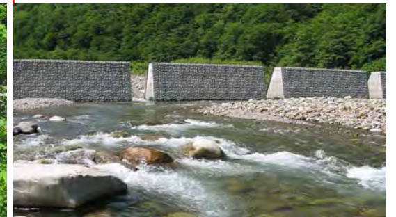
▲戸蔭別川 第5号堰堤
