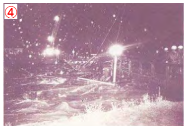
▲昭和56年8月洪水 売買川鉄平橋の撤去(帯広市)
