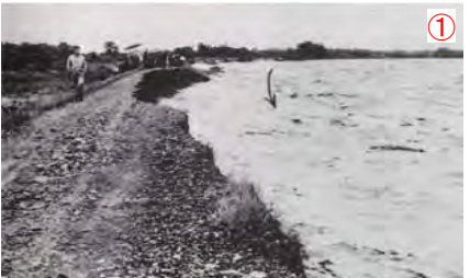
▲昭和37年8月洪水 札内川右岸決壊した加賀築堤(帯広市)
