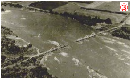
▲昭和37年8月洪水 流出した札内川上札内橋(中札内村)
