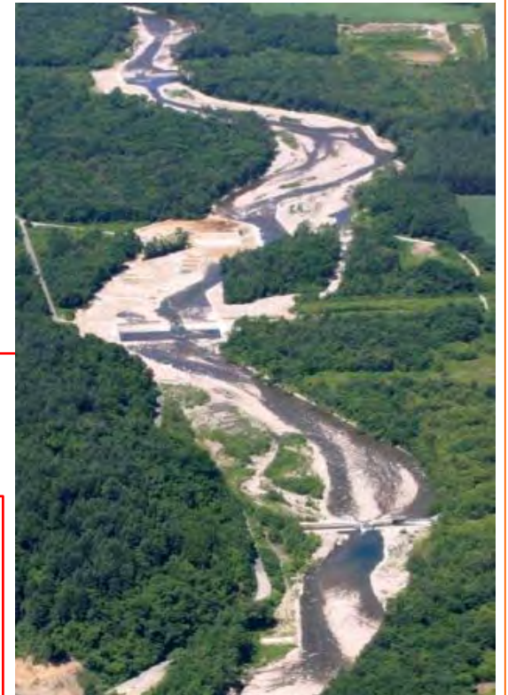
▲戸蔭別川の床固工群
